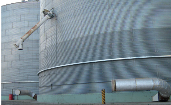
Figura 14. Conexiones fijas para acoplar el equipo refrigerador al silo con conductos de aireación previamente dimensionados.
