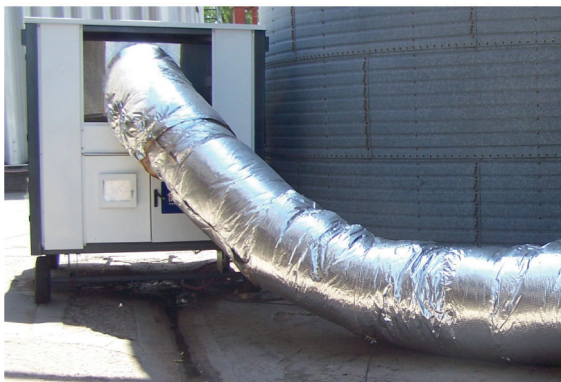
Figura 15. Escurrimiento del agua proveniente del refrigerador a través de un canal ya conformado.
