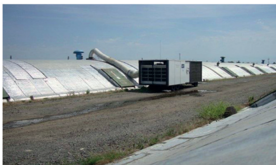
Figura 17. Silo subterráneo en proceso de refrigeración.
