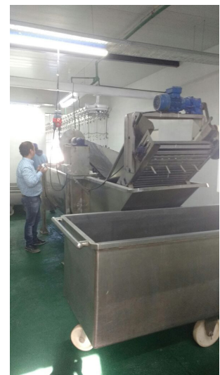
Ing. Zoot. Marcos Auat. Montaje, puesta en marcha y adiestramiento del personal de planta de faena de aves, Pomán, Catamarca, Argentina.
