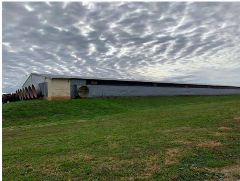
Figura 5: Galpón 5 de ambiente controlado.
