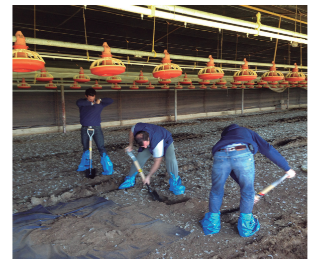
FOTO 2. Cavado de canaleta.
