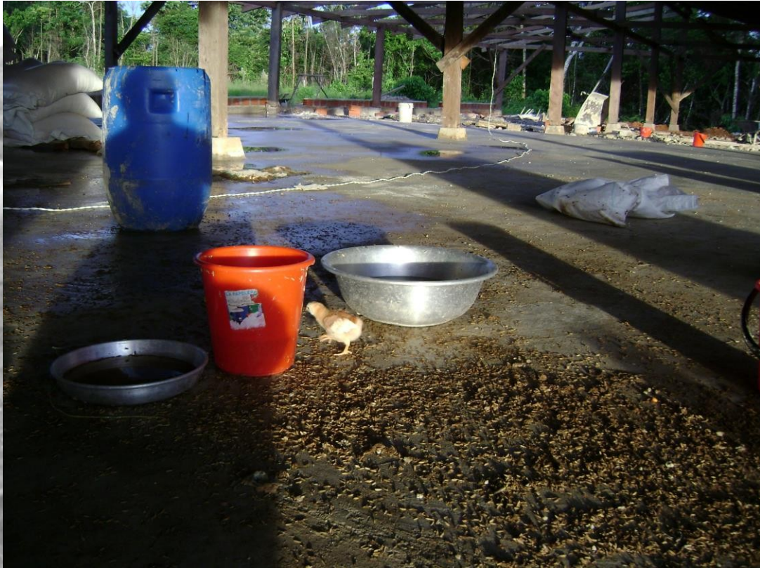
Galpón de aves en construcción de piso de cemento o concreto con postes de madera y techo de teja de Duralit, que facilita mejor manejo para la limpieza y desinfección cada vez que se realice la saca
