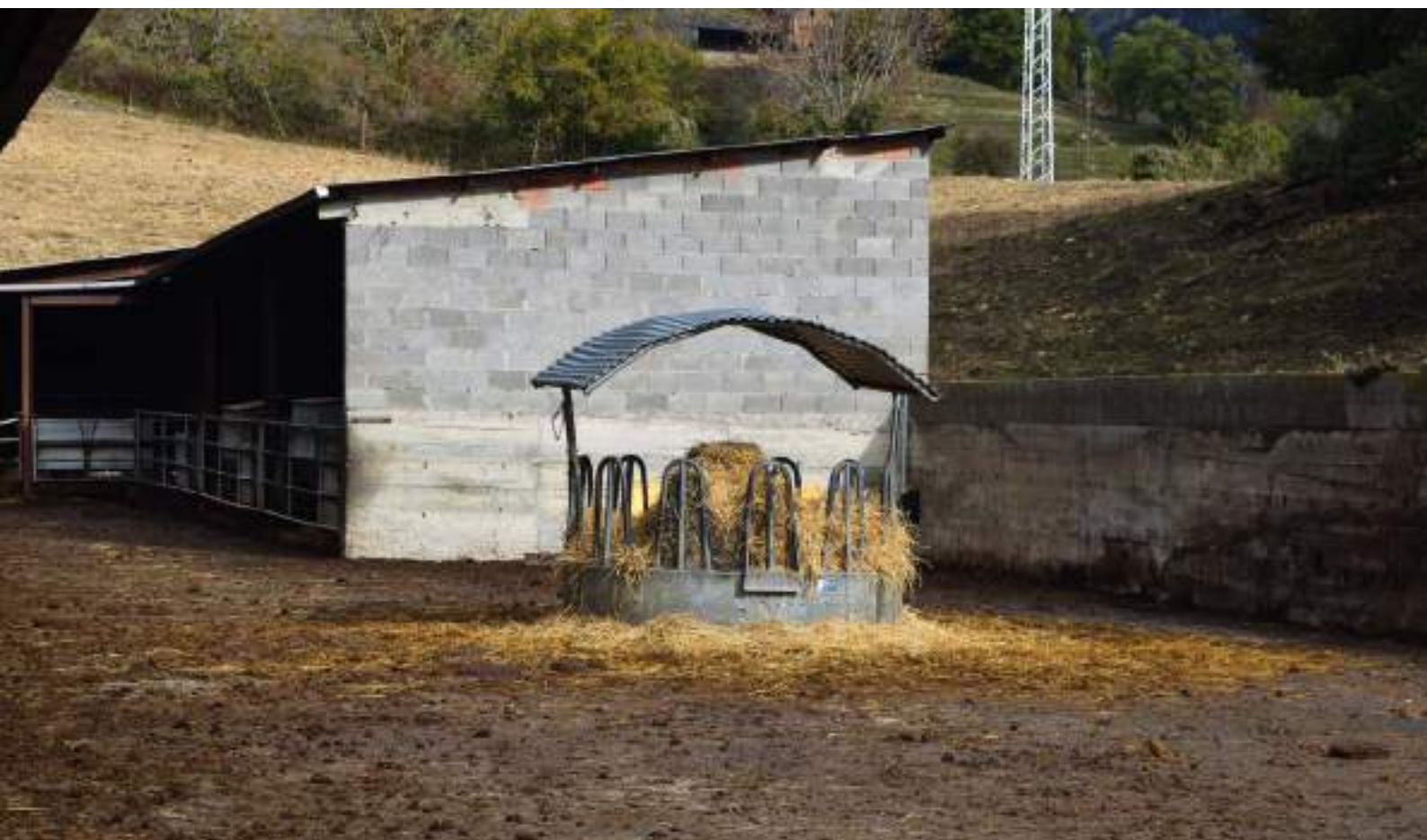
Figura 3.4.- Pajera en recinto cerrado con techo propio.
